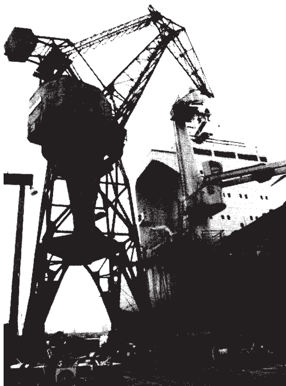
Skibet ligger ved udrustningskajen. Her monteres dels skibets indre dele, dels udføres der montering af kranfaciliteter.
