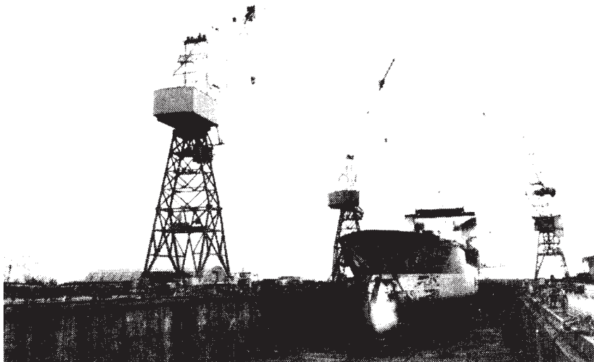
Skibet lige før det forlader byggedokken og transporteres til udrustningskajen.
